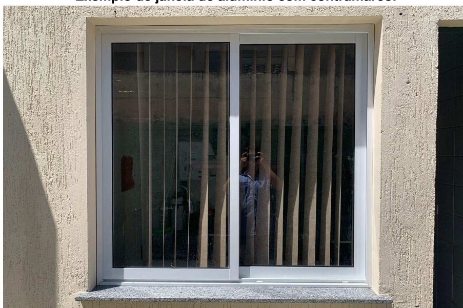
Exemplo de janela de alumínio com contramarco.
